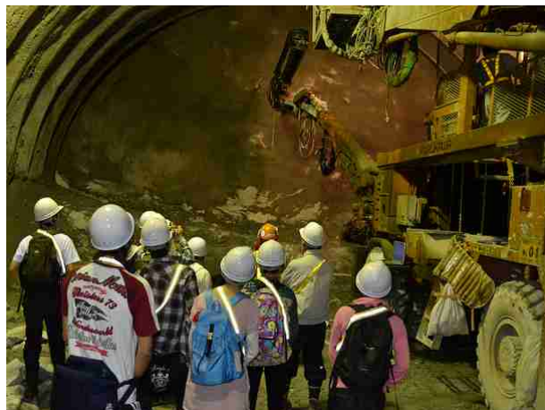
掘削現場の見学
