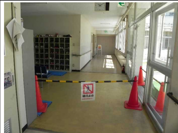
出火場所（防火扉も閉まりました）
