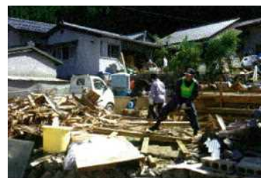
【倒壊した小屋の片付け H23.9.11撮影】
