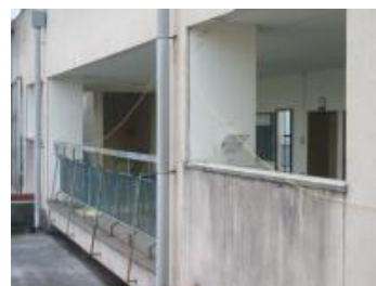
図11 壁に沿わせたケーブル
