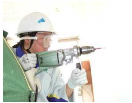
図20 振動ドリルで教室の壁に下穴をあける女子生徒
