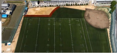
御所実業高校の人工芝工事を行いました。
