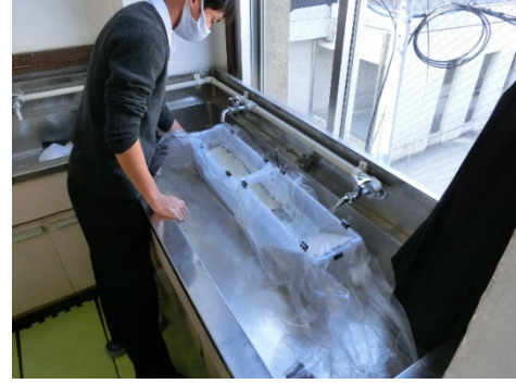
津波の被害を減らすには
