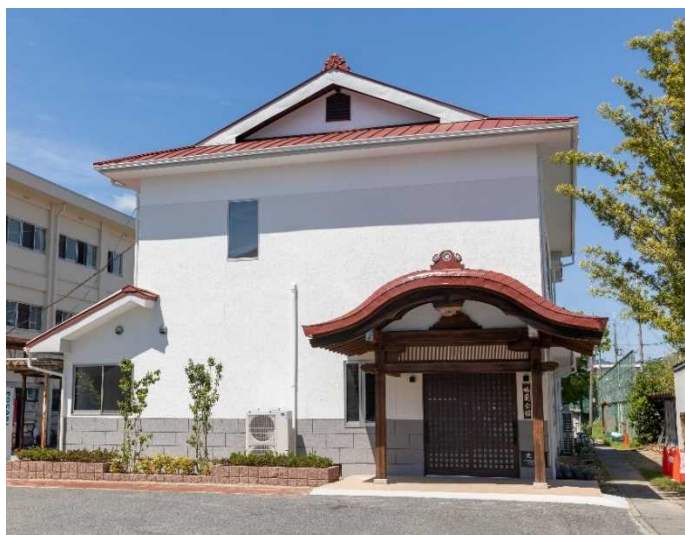
改修工事後の鳩蘭会館(同窓会館)
