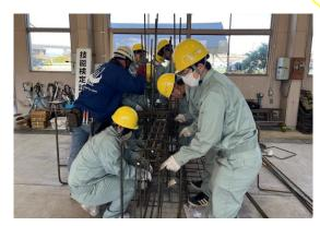
実際に行われる[鉄筋施工技能士 |級の実技試験]の問題を体験しました。 「ハッカー」で「結束線」を使って鉄筋を固定していく作業は、簡単そうに見えて難しい作業でした。
