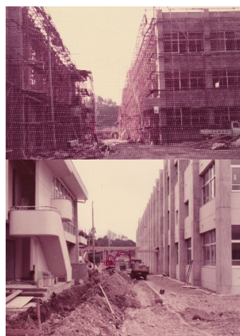
【体育館(左)と南館(右)の工事の様子】
